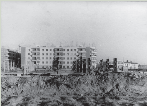
Edificios en construcción.
